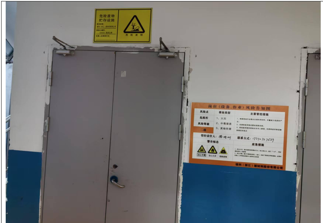
图 9-1 本项目危废暂存库
