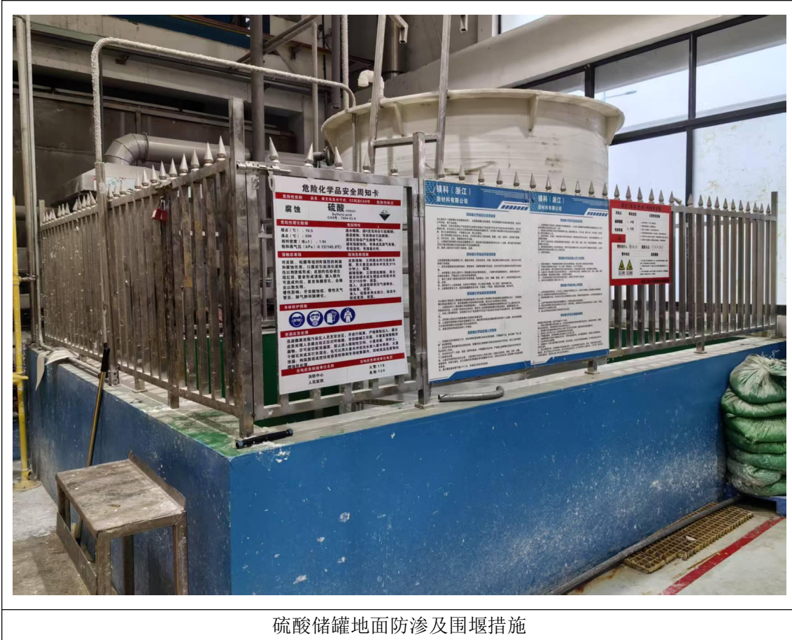
图 4-4 硫酸储罐区域地面防渗及围堰照片
