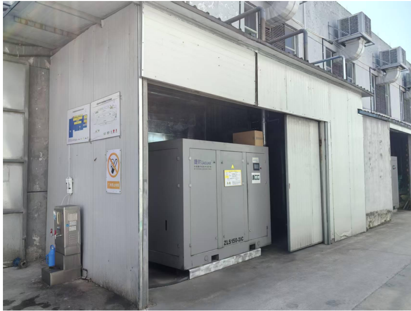
图 4-4 中央真空、空压机房整体隔声
