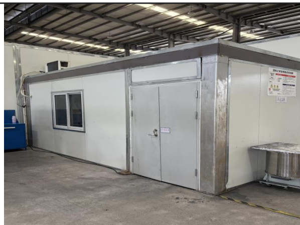
配比投料、混料（密闭车间外部）
